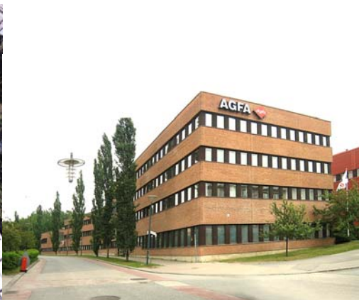
Befintlig kontorsbyggnad på kv Lidarände
