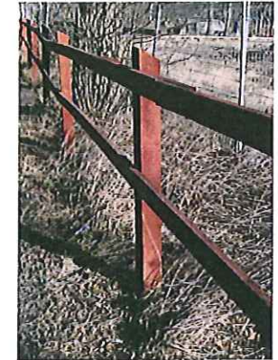
Befintligt trästaket i området.
