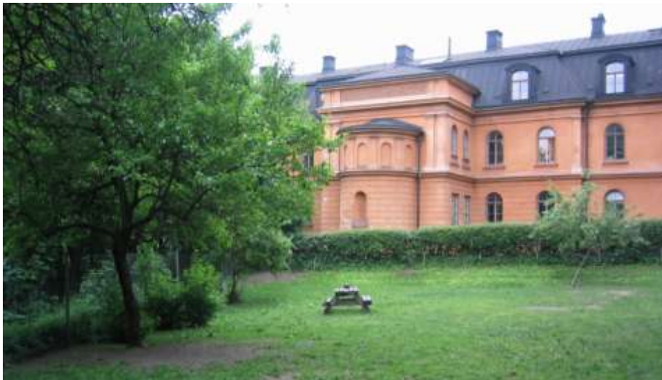
Oskar I:s minne sedd från Mariagårdstäppan.
