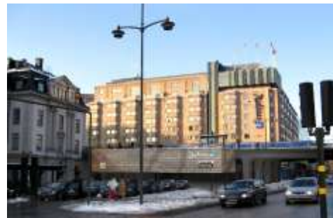
Figur 7, Cykelgarage under Klarabergsgatan, Jernhusen (2009-12-10)
