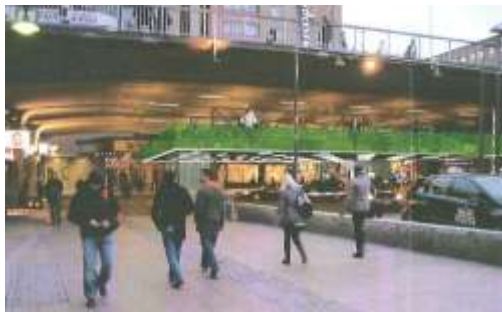
Figur 6, Cykelgarage under Klarabergsgatan, Jernhusen (2010-02-22)
