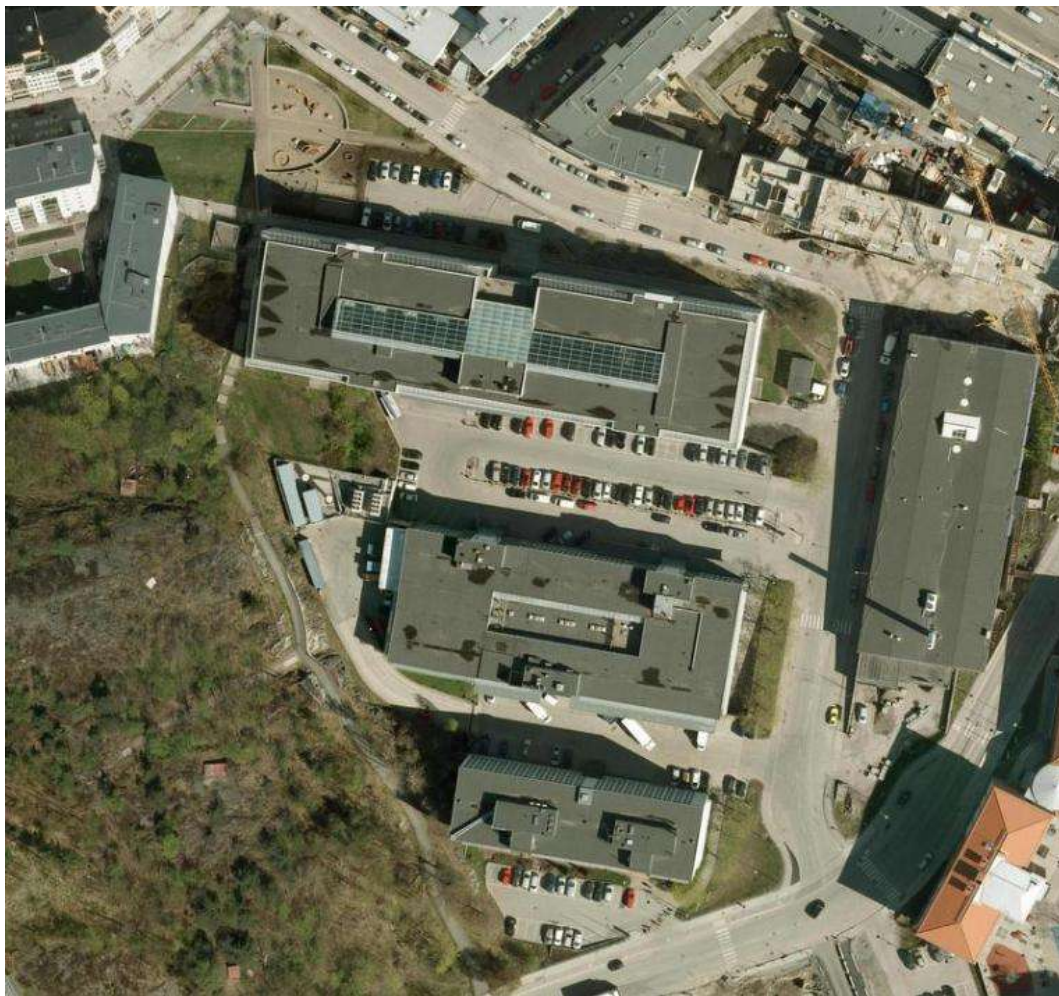
Ortofoto där markanvisningsområdet i princip motsvarar den mittersta byggnaden samt befintlig kvartersmark runt den.
