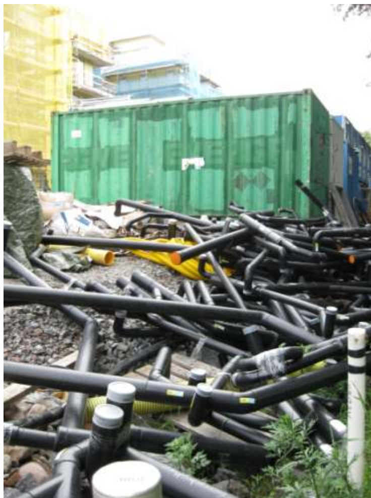
Bild 4 Lagerhållning av material på arbetsplatsen – avloppsrör för ingjutning i betongbjälklag Foto Kristin Brunge
