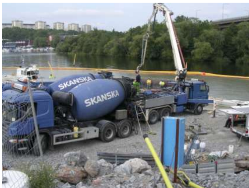
Bild 1 Betonggjutning just-in-time-leverans Foto Fredrik Bergman
