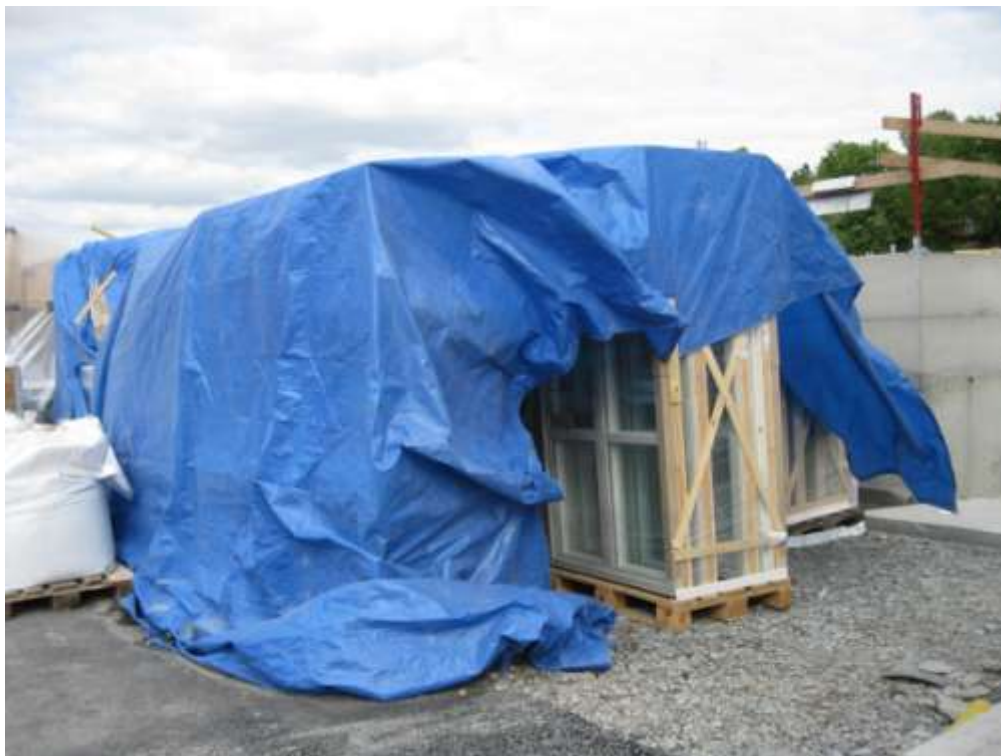
Bild 3 Lagerhållning av material på arbetsplatsen – fönster Foto Kristin Brunge
