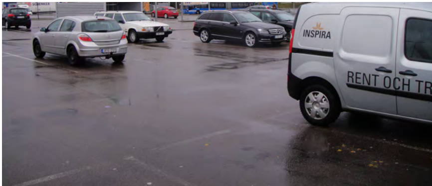
Körbana och parkering med asfaltsbeläggning.
