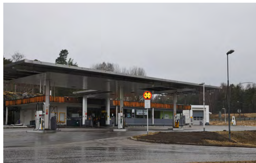
Foto från platsen innan rivningen av bensinmacken påbörjades.
