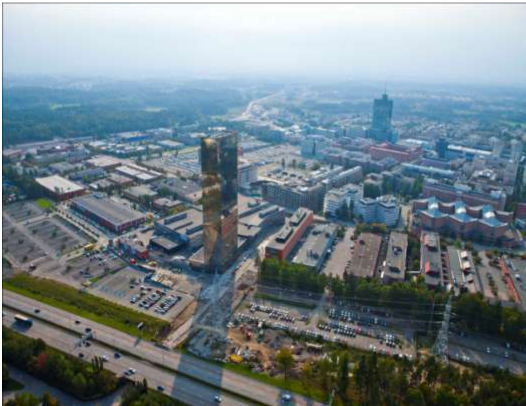
Victoria Tower med Kista Science Tower i bakgrunden
