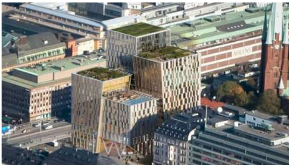
Illustration som visar de fyra volymerna och dess takutformning. Nerifrån i bild syns skybarens publika terrass, därefter terrassen för hotellgäster. Närmast Klara kyrka ses bostadsgården och överst det gröna sedumtaket. (3xN och Tenjin)
