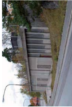
Figur 5.8.1. Transformatorstation på Björnåsvägen. Stationen inrymmer SLS-flikarstation och förarnas transformatorstation som försöljer tunnelbanan respektive närområdet med el.
