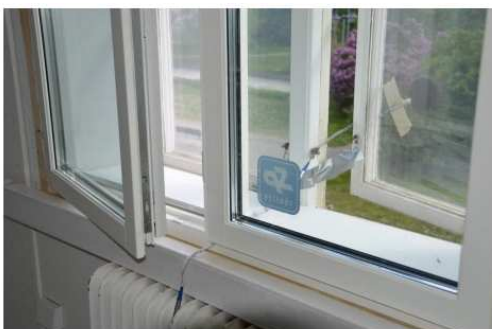
Vädringsöppet läge för det dubbla fönstret.
