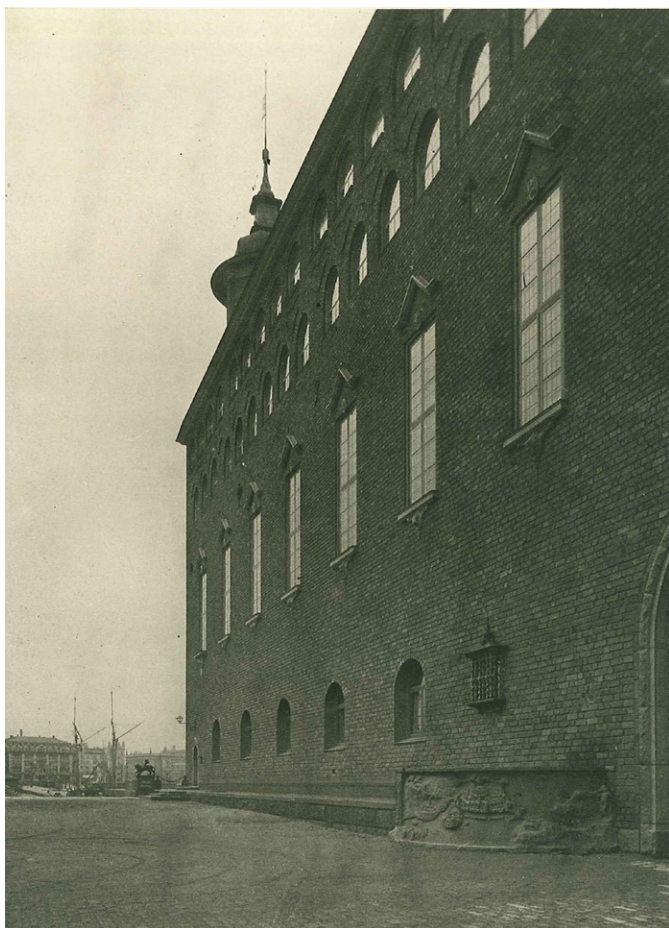
85. Norra fasaden var medvetet nedtonad i sin utformning.
