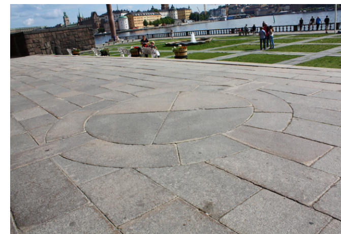
Bild 23 och 24. Romboida och cirkulära mönster i granitbeläggningen.
