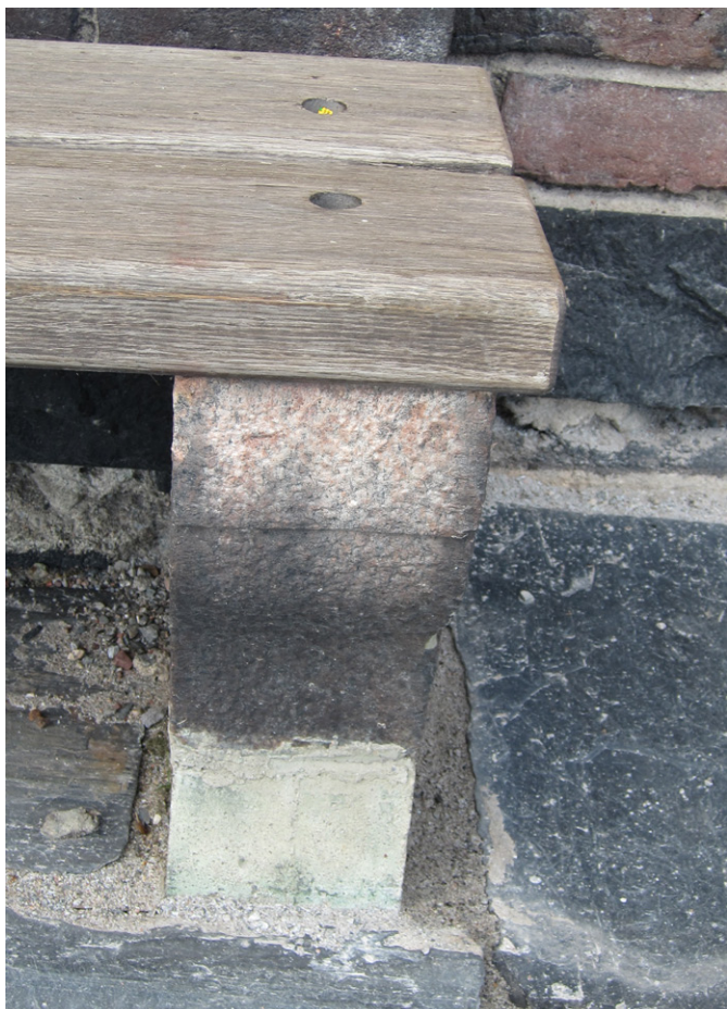
78. Bänkarna har höjts med betong, Östra Terrassen.
