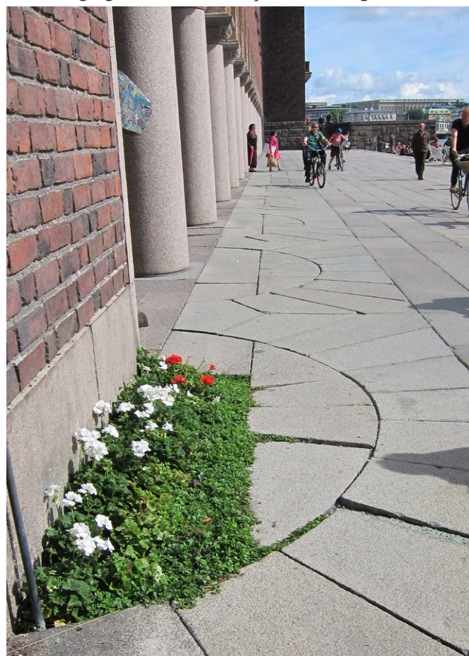
22. Granitstenen i den bågformade markbeläggningen har satt sig.
