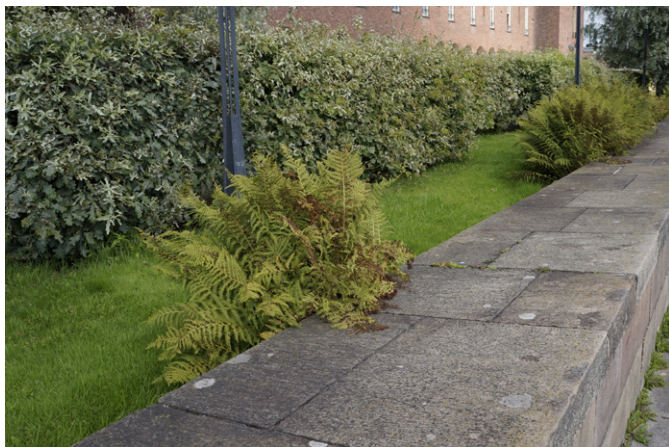
63. Ormbunkar växer längs muren, Broderiparterren.
