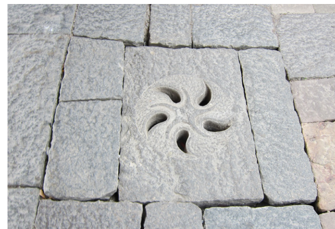
7. Dagvattenbrunnar i granitsten.
