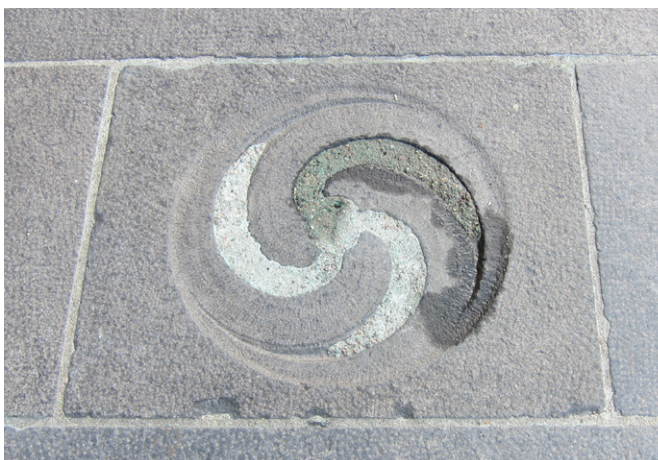
92. Dagvattenbrunn igenfylld med betong.
