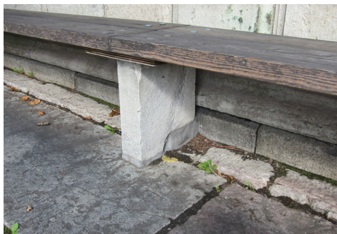
52. Bänkarna har höjts upp med betong.
