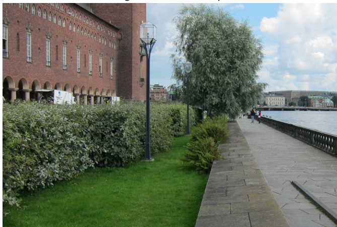
64. Belysningsarmaturer i gräsmattan i Broderiparterren.
