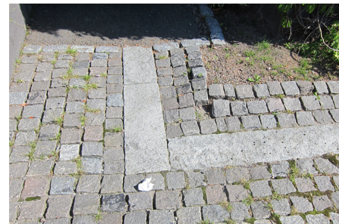
97. Markbeläggning av rödaktig smågatsten och ljusa granithällar.
