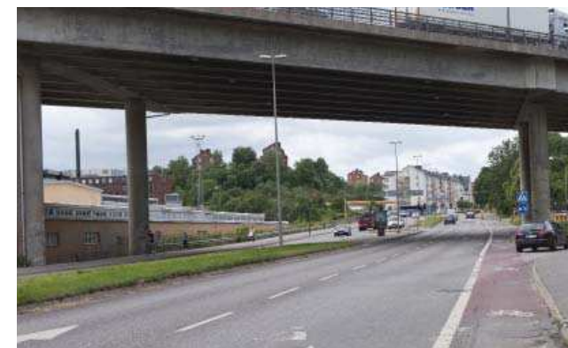
Hägerstensvägen mot entrén till Aspudden. Nybodadepån till vänster
