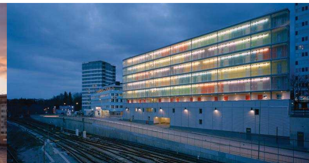
Exempel på hus som bullerskärm. Studentbostäder i Högdalen. Scheiwiller Svensson arkitektkontor. Foto: Åke E:son Lindamn.
