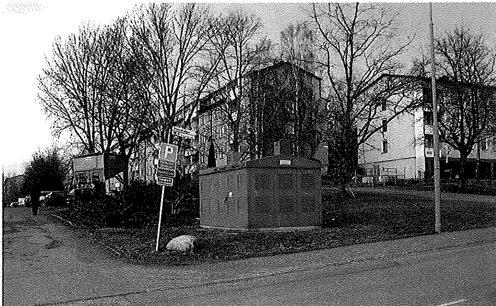
Byggnader inom Tempelriddarorden 7, samt elnätstation vid Frimurarvägen. Till vänster i bilden skymtar parkeringsplatser inom Tempelriddarorden 7 och 10.
