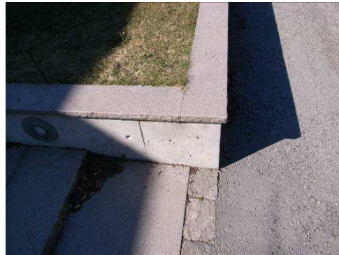
Referensbild: Betongmur med täckning av natursten
