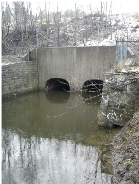
Kulvert under järnvägen
