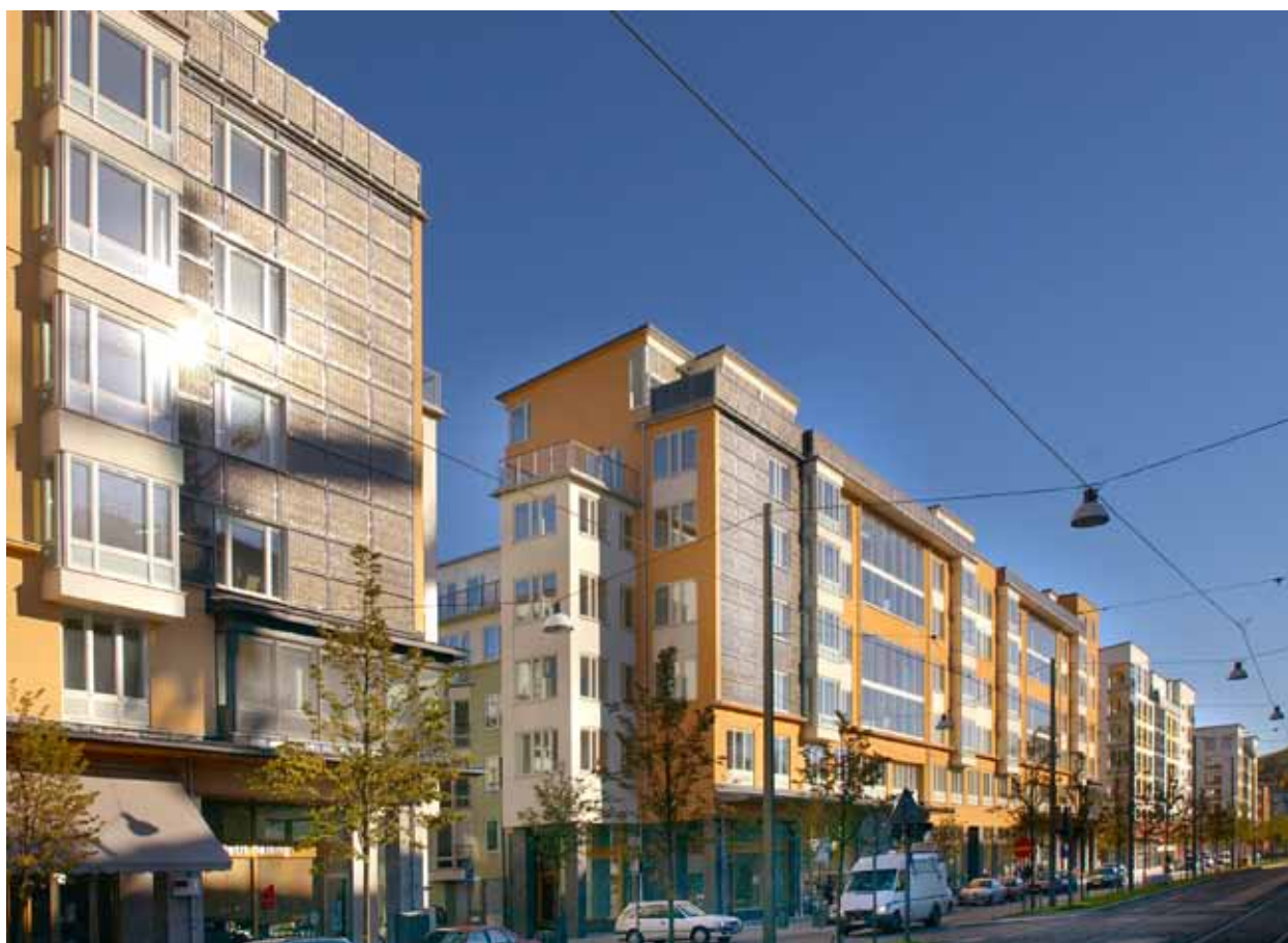
Solpanel som fasadelement, Hammarby Sjöstad.
