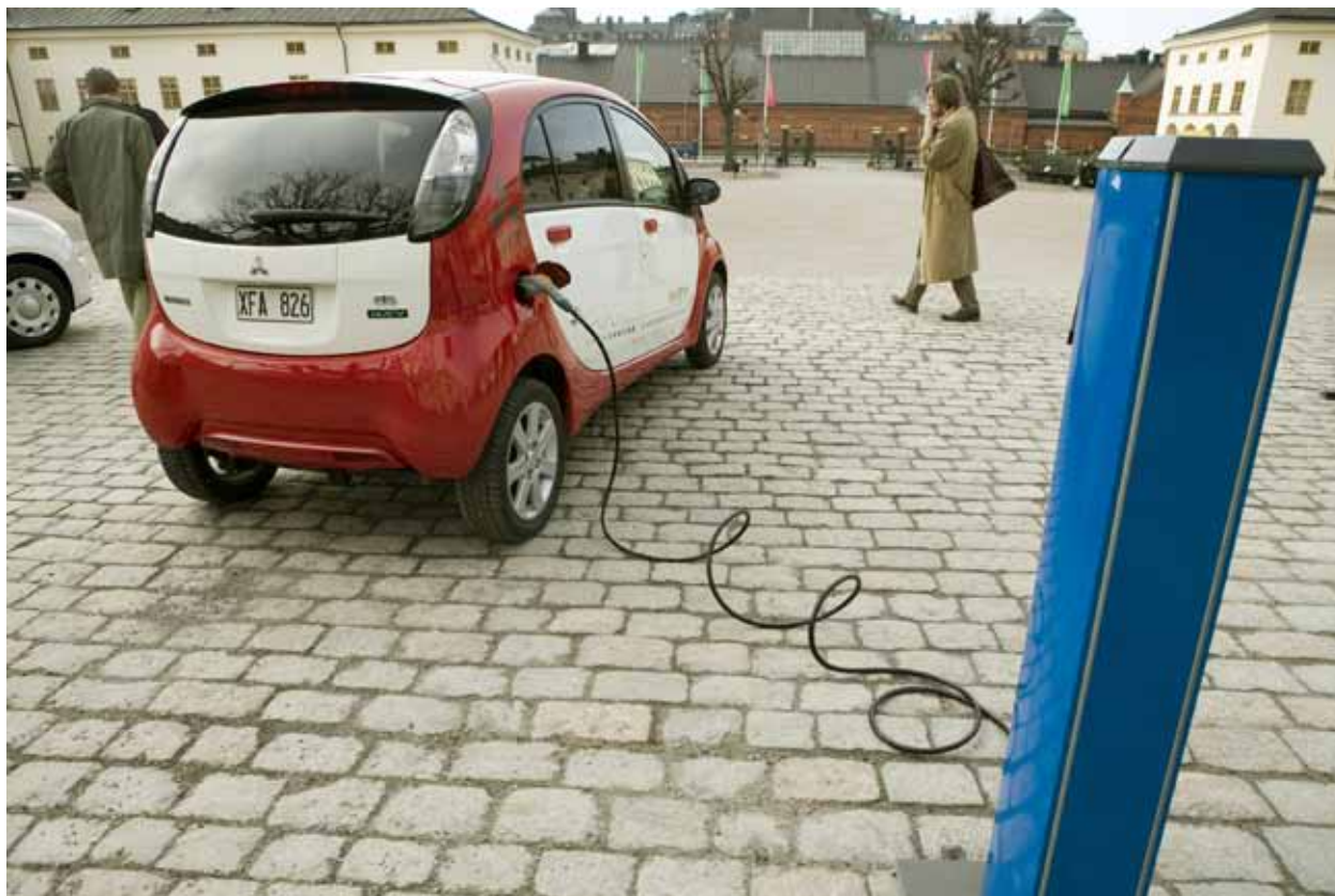
Elbil och laddstolpe
