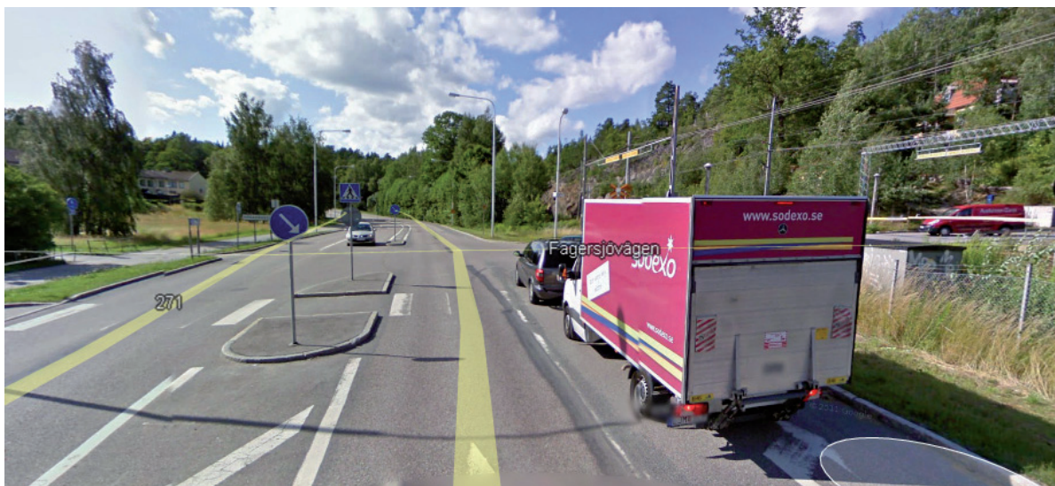
Korsningen Magelungsvägen/Fagersjövägen. Observera den dåliga sikten vid övergångsstället och det dåligt underhållna övergångsstället.
