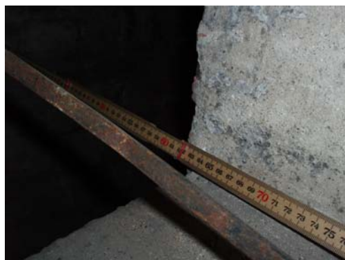
Gavelvägg hus 12 samt avstånd till gavelvägg hus 10 (ca 60 cm)
