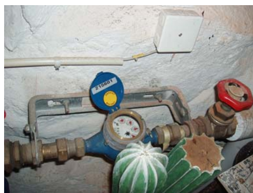
Mätning inkommande kallvatten hus 10
