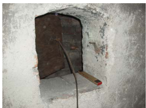
Gavelvägg med inspektionsslucka hus 12, tjocklek ca 25 cm
