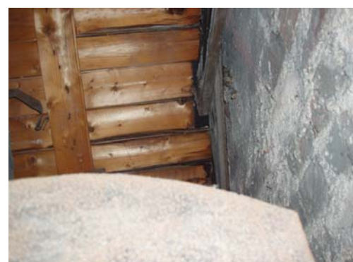
Takkonstruktion i blindutrymme i hus 12 vid anslutning till hus 10
