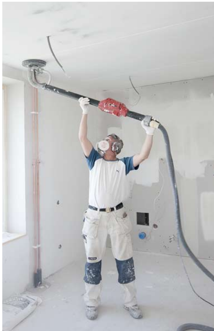
Ombyggnad av smalhusfastighet på Brännkyrkagatan 131.
