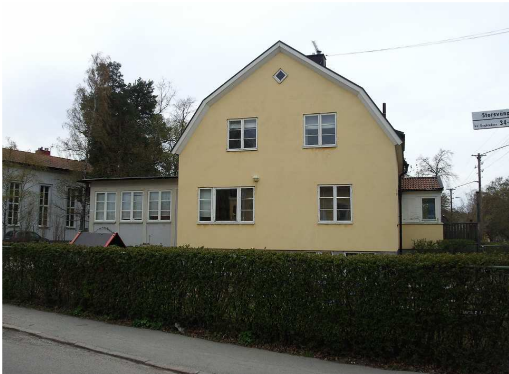
Fasad ut mot Storsvängen
