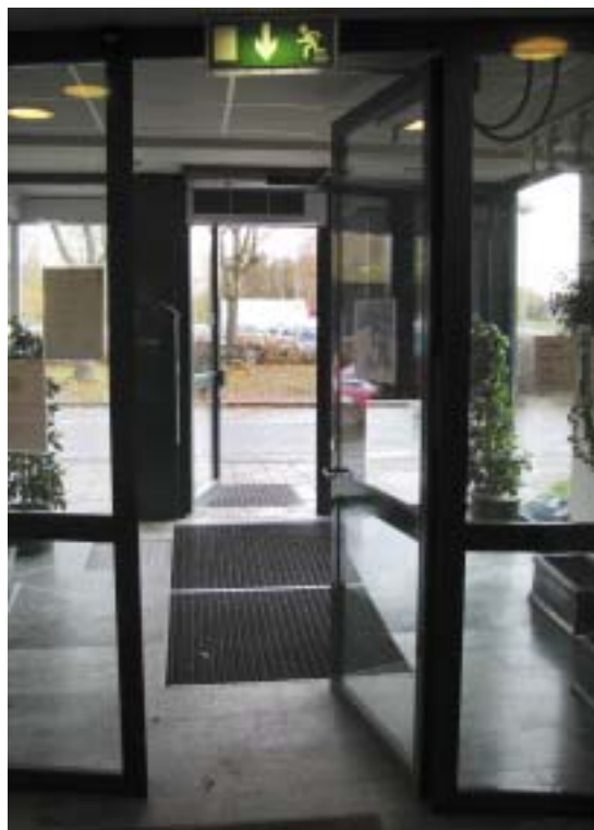
Entréddörr till C3L efter installation av automatisk dörröppnare.
