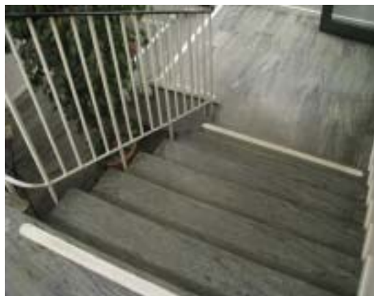
Kontrastmarkerade trappsteg i C3L:s huvudtrappa.
