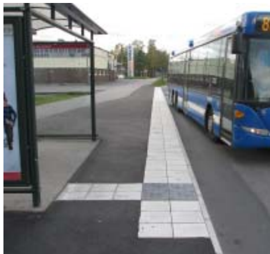
Ombyggd hållplats vid Bollmoraberg
