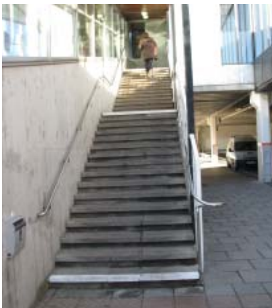
Utvändig kontrastmarkerad trappa.
