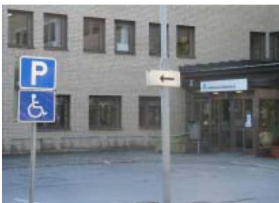
Bollmora vårdcentral i Tyresö centrum
