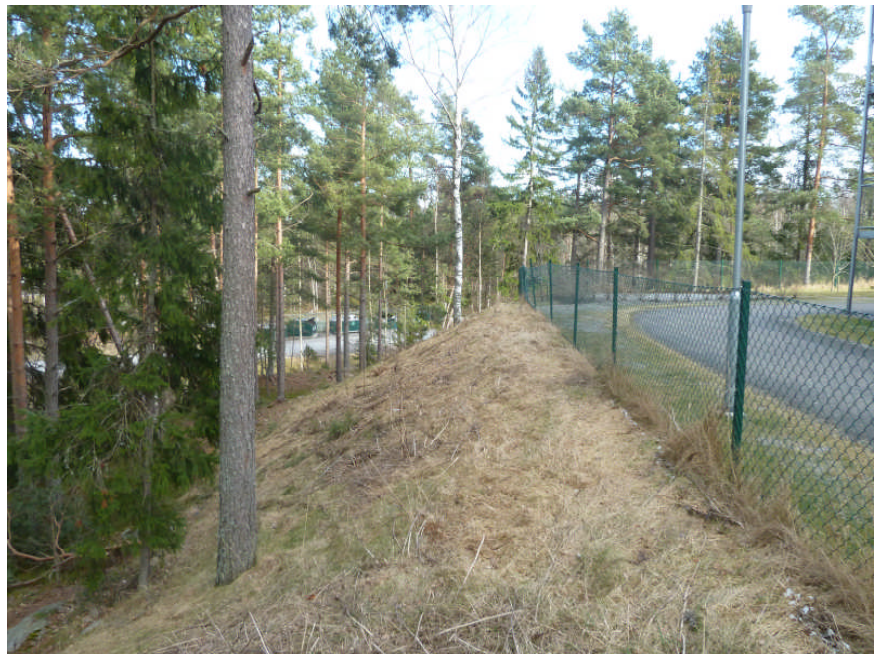
Den anlagda slänten i områdets nordöstra del.
