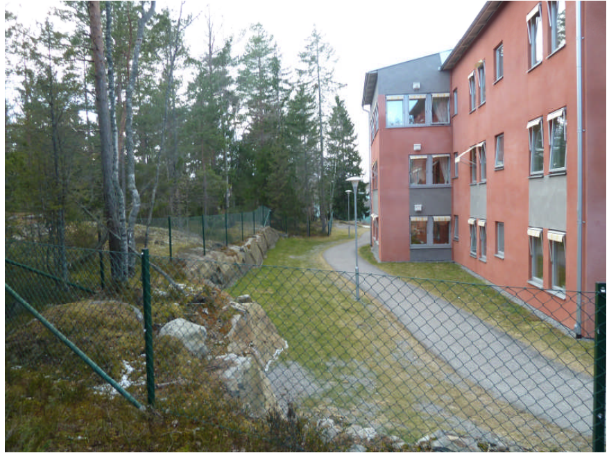
Befintlig bebyggelse inom planområdets mellersta/norra del.
