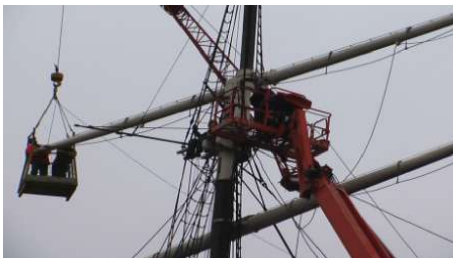
Vid såväl demontering som montering av master och rår behövs två kranar, vilket kan bli aktuellt 2018 om kontoret finner att trämasterna behöver bytas
