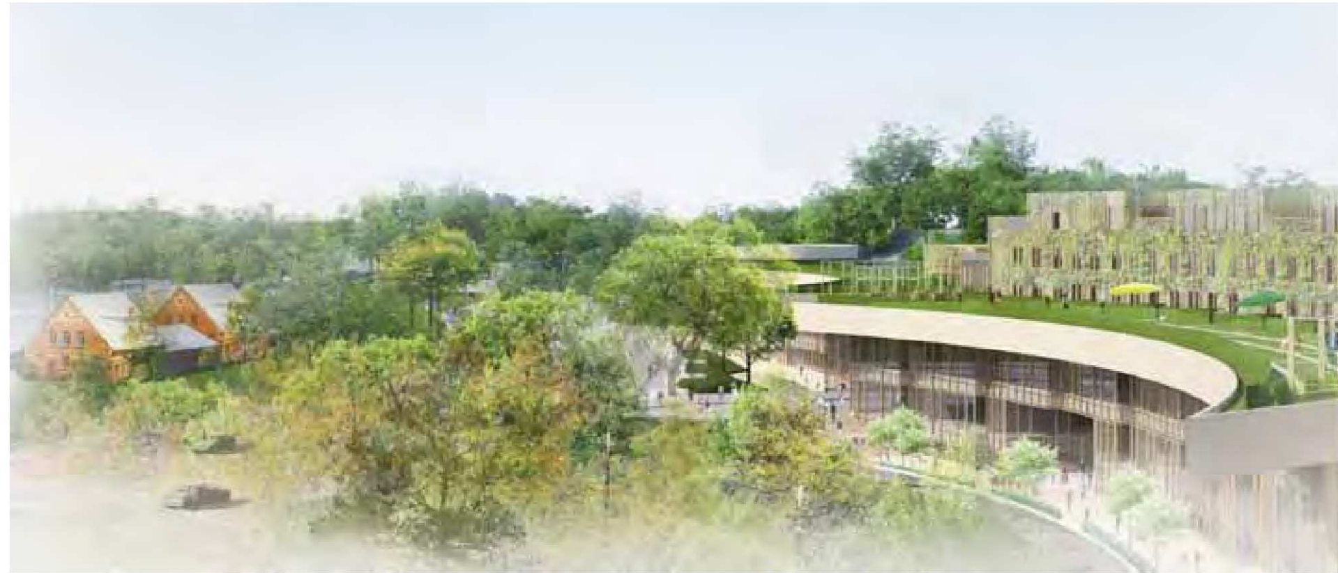
Taklandskap mot kvarter 14, 16 och 23, mot norr.
