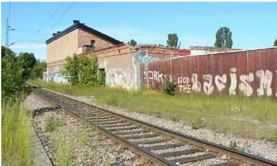
Figur 5.2.4 Före detta industribyggnad sedd från Värtabanan.
