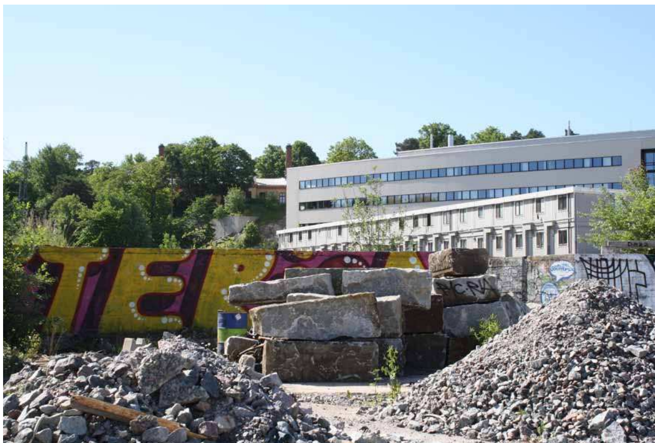
Figur 5.13.1 Upplag vid bygge i Albano. Foto: Catarina Holdar, juni 2010.
