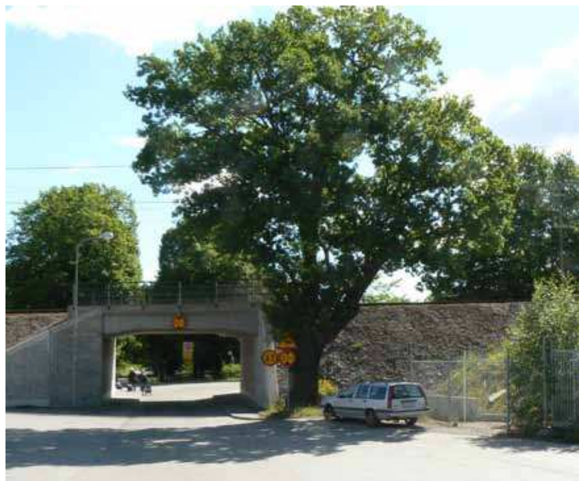
Figur 5.2.1 Den stora eken vid Björnnäsvägens port under Roslagsbanan. Här låg den forna entrén till jaktparken.
