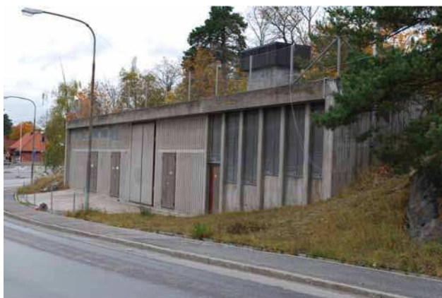
Figur 5.8.1 Transformatorstation på Björnäsavägen. Stationen inrymmer SL:s likriktarstation och Fortums transformatorstation som försörjer tunnelbanan respektive närområdet med el.
