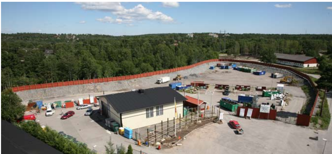
Kretsloppscentralen, etapp I under utbyggnad 2006. Foto: Hasse Saxinger
