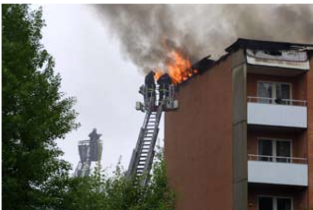
Eldsvåda på taket i ett flerfamiljshus. Foto: Hasse Saxinger
