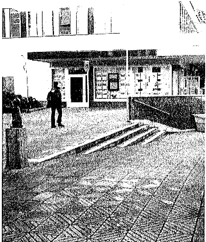
Utvändig kontrastmarkerad trappa i Tyresö Centrum.
