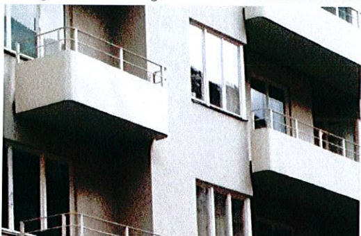
Referens på balkonger med överligger vid burspråk
