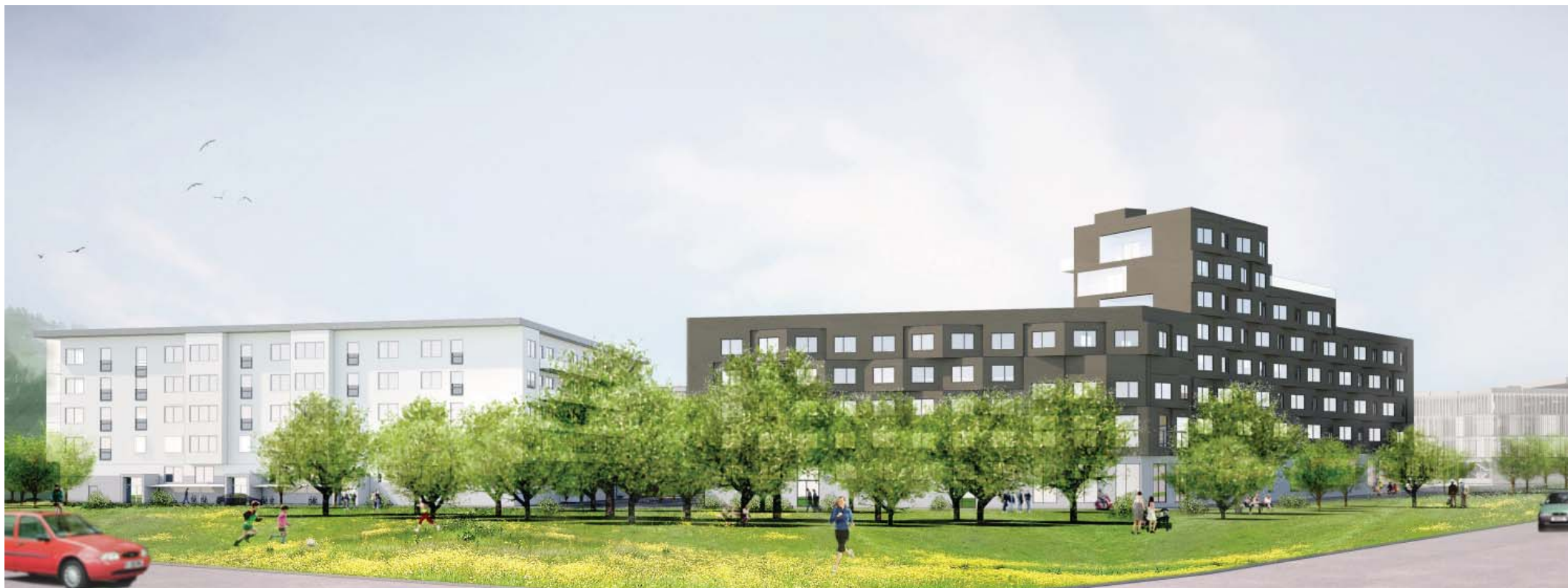
Vy på Hus 1 och 3 från nya rondellen på Tyresövägen
