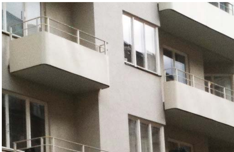
Referens på balkonger med överliggare vid burspråk
