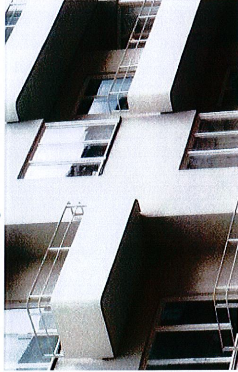
Referens på balkonger med överliggare vid burspråk
