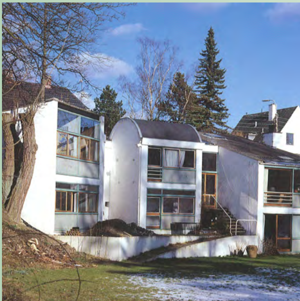
Referensbild, fönsterpartier med fyllning
