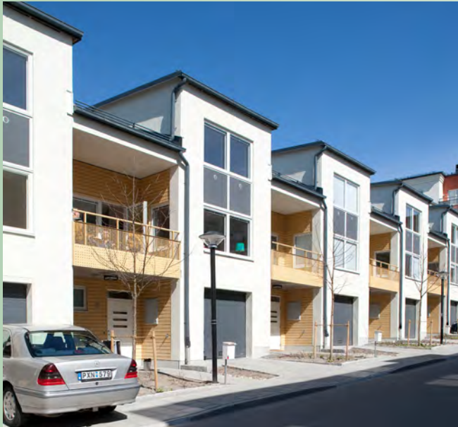
Referensbild, kv Armborstet, Älvsjö
