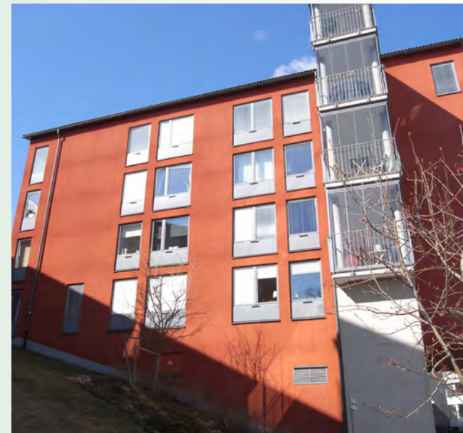
Referensbild, fönsterpartier med fyllning
