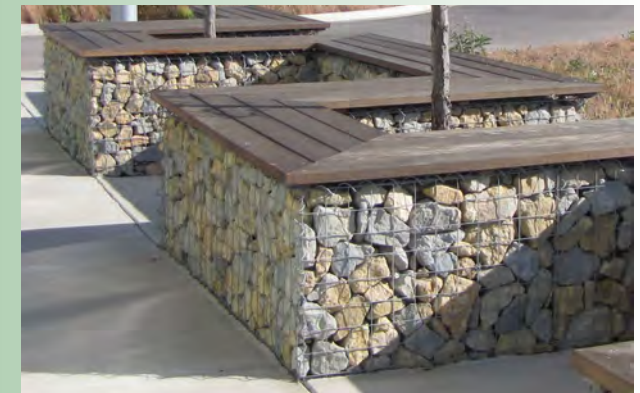
Inspiration LOD - mur av gabioner
