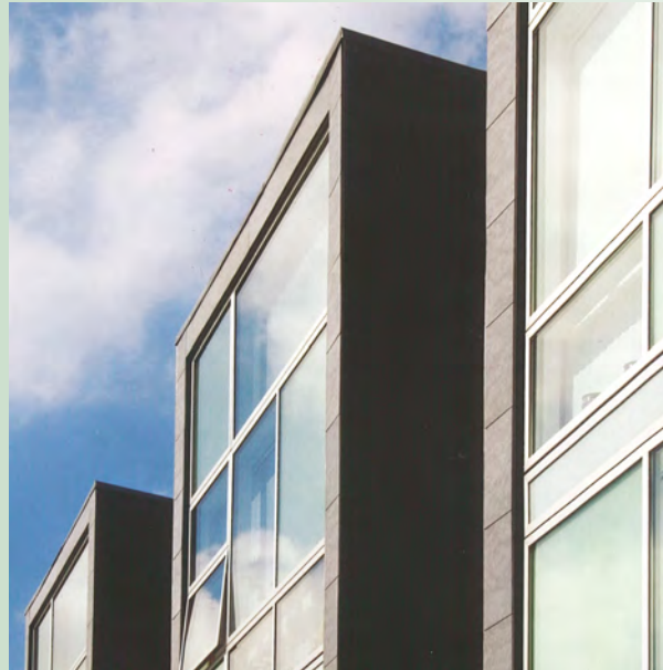
Referensbild, fönsterpartier med fyllning
