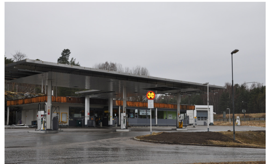
Foto från platsen innan rivningen av bensinmacken påbörjades.
