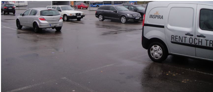
Körbana och parkering med asfaltsbeläggning.
