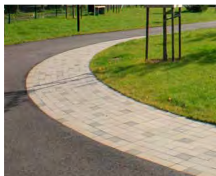
Band av betongmarksten intill asfaltyta
