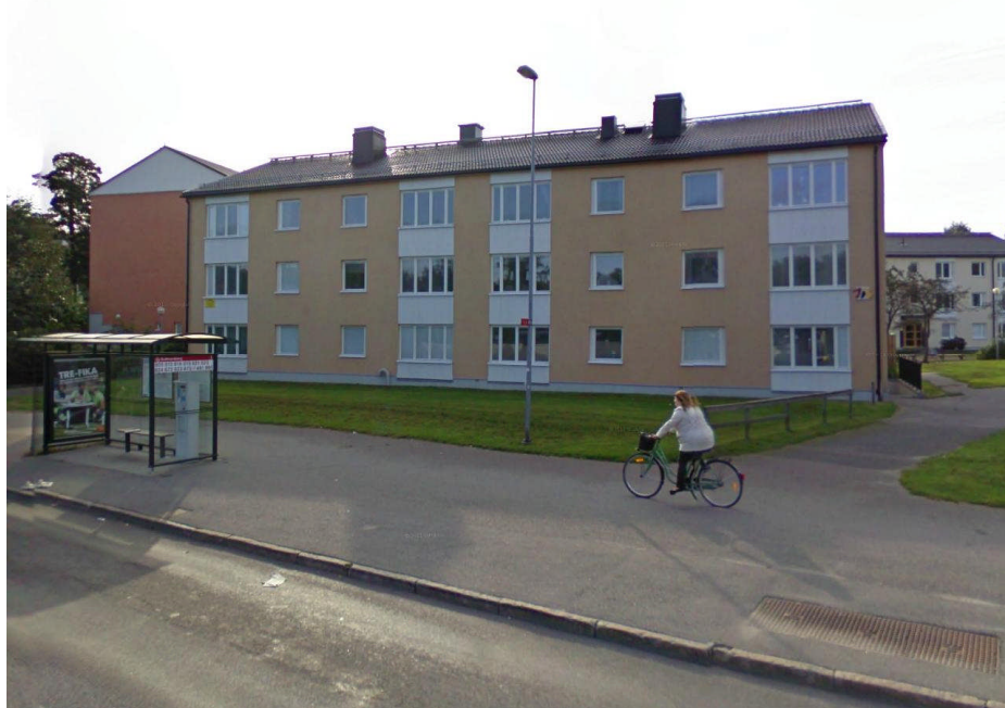
Bilden visar befintlig bostadsbebyggelse, Pluggvägen 21-23 som kommer att behöva rivas. Bildkälla: Google streetview
