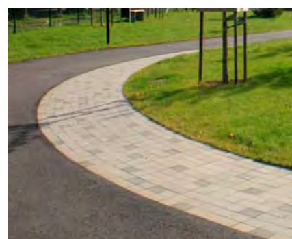
Band av betongmarksten intill asfaltyta
