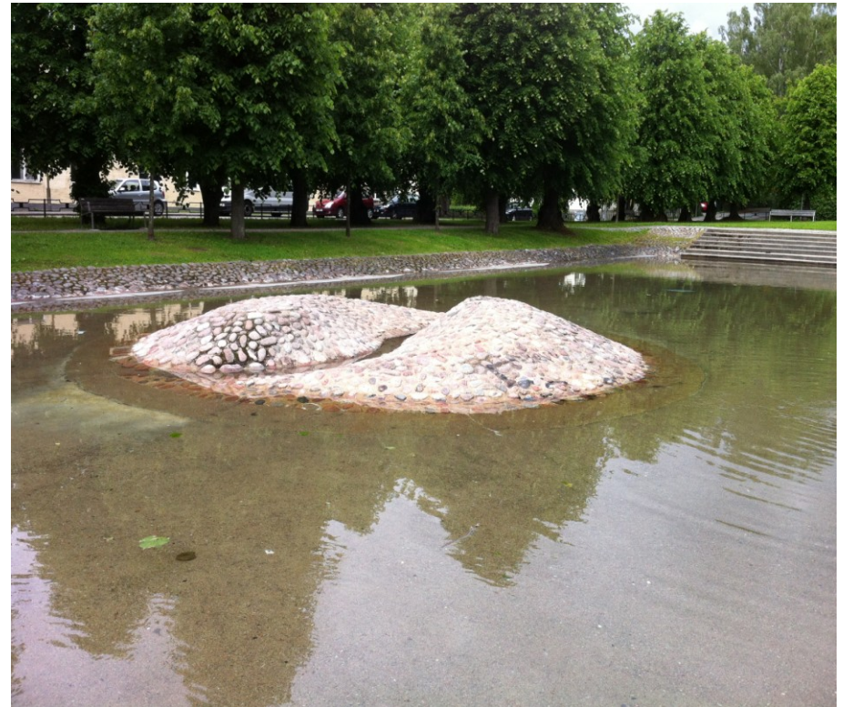
Ön i mitten saknar dysor, vatten kan bli stillastående
