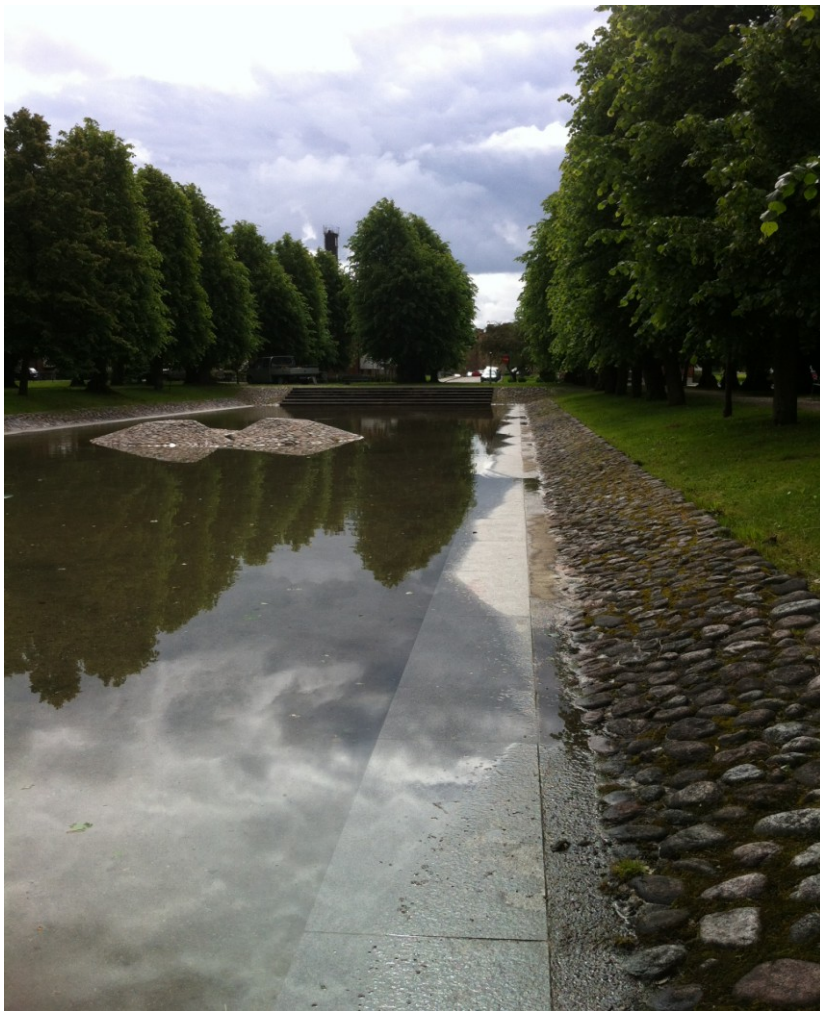
Då kröning saknas förs material från sluttningarna ner i dammen helt fritt.
