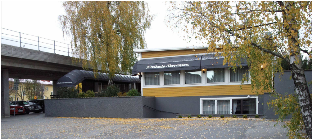
Fasad ut mot Sockenvägen
