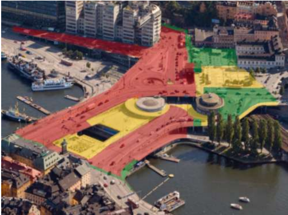
Bild 3. Slussen tekniska status. Rött redovisar mycket dåligt skick, gult relativt dåligt skick och grönt områden som är i relativt gott skick.
