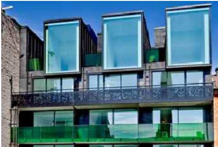
Referensbild med stora rektangulära takkupor med smäcker takfot och detaljering. Samt balkongräcke som täcker balkongplattans front. (Referensbild: bostadshus i Oslo av Ramstad arkitekter)
