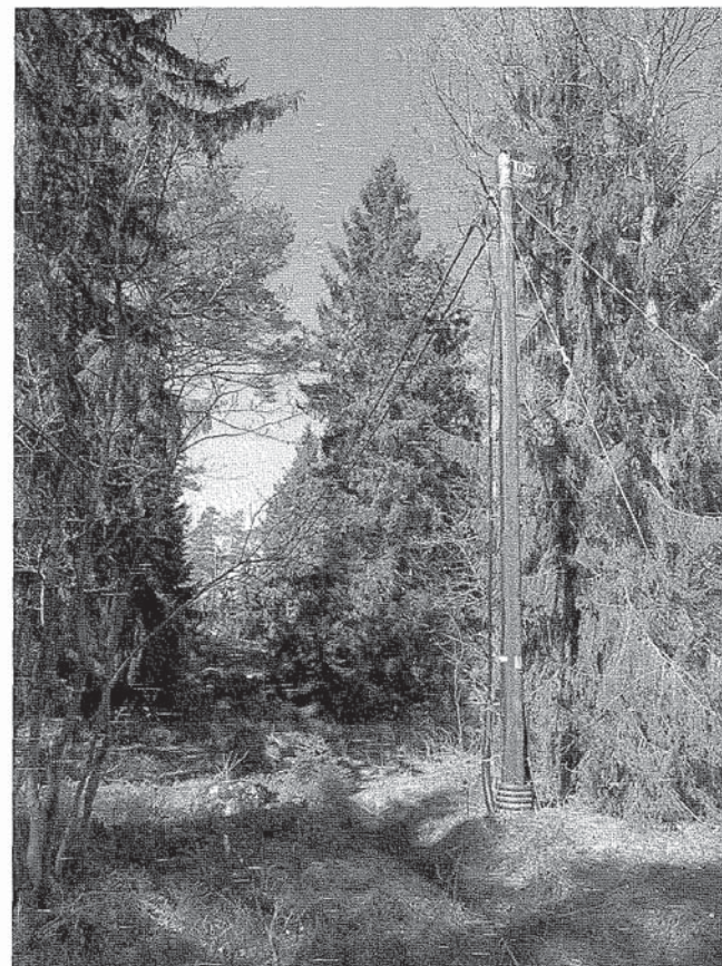
Figur 8 Luftledning med hängkabel, 10 kV
