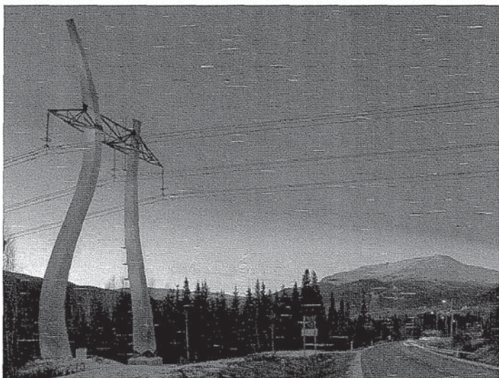
Figur 11 Exempel på en s.k. designstolpe för 400 kV
