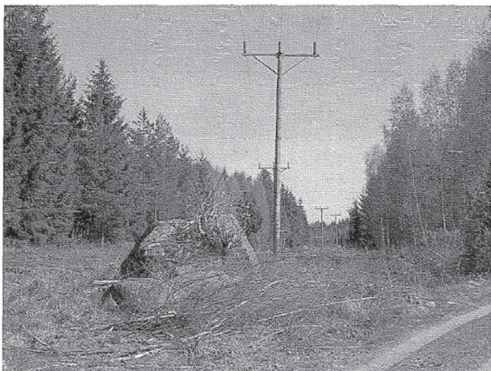
Figur 6 Luftledning med oisolerade ledare, 40 kV
