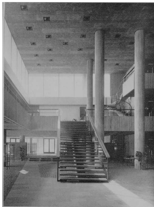
Entréhallen mot söder, Ur Arkitektur nr 9 1960.
