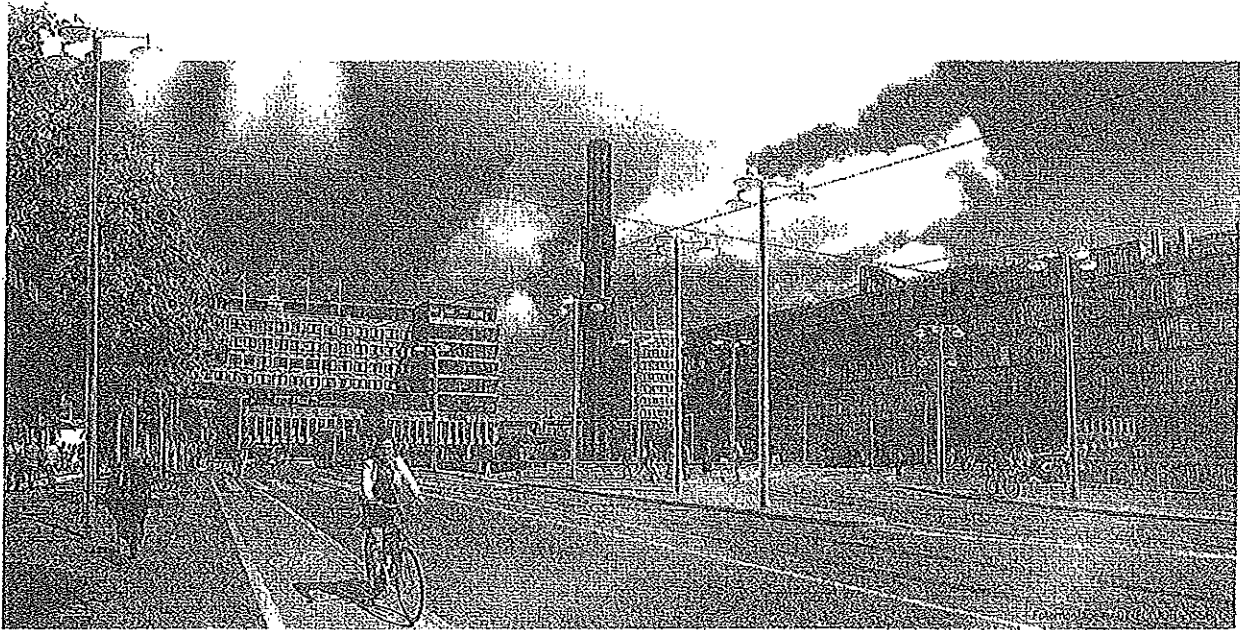
Illustration av förändrade belysnings- och kontaktledningsstolpar samt kontaktledning vid Sergels torg. Bildens visar även hur kontaktledningens bärlinor fästs i stolpar samordnat med belysningen
