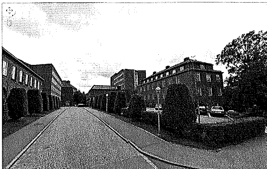
Teknikringen sedd från norr, byggnad 43:10 till höger
