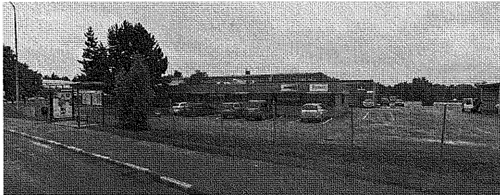
Befintlig byggnad sedd från Bromstensvägen
