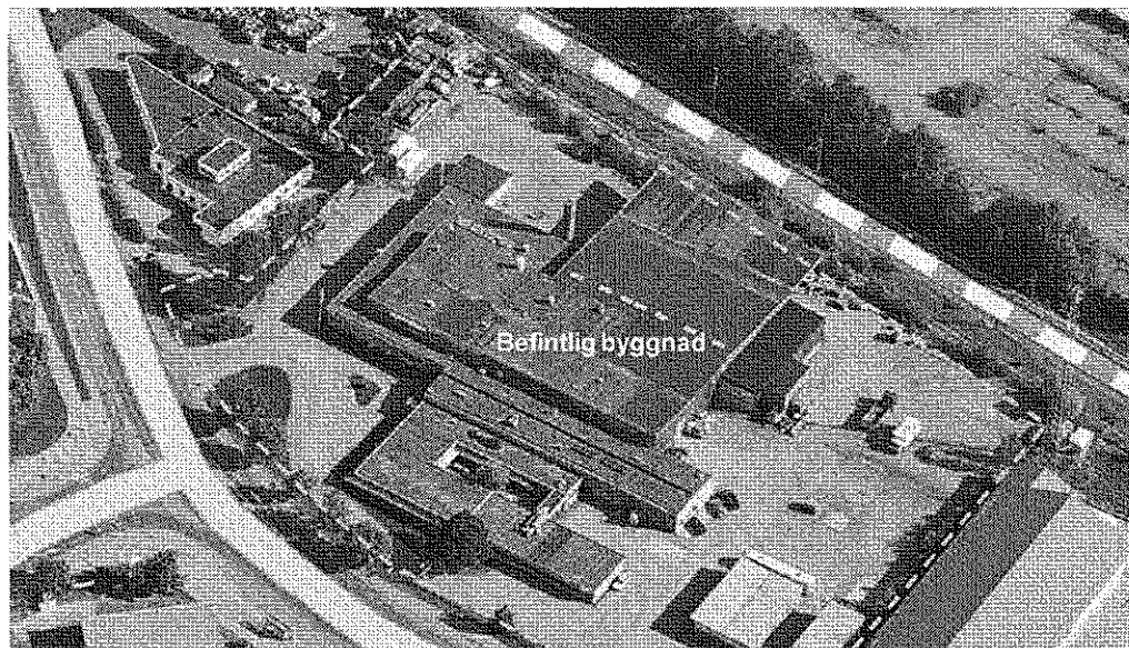
Befintlig byggnad sedd från söder
