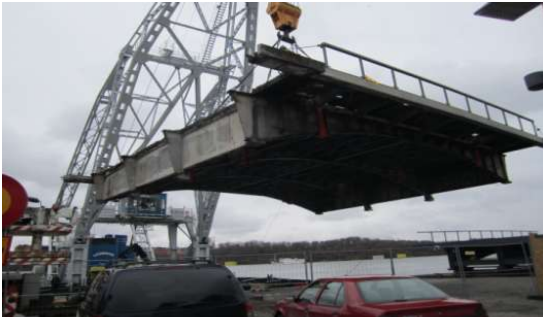
Stadshusbrons gamla klaff lyftes bort till Norrmälarstrand, där den nya klaffen väntade.
