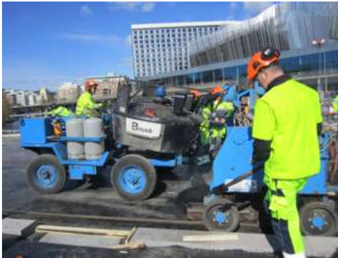
Läggning av gjutasfalt
