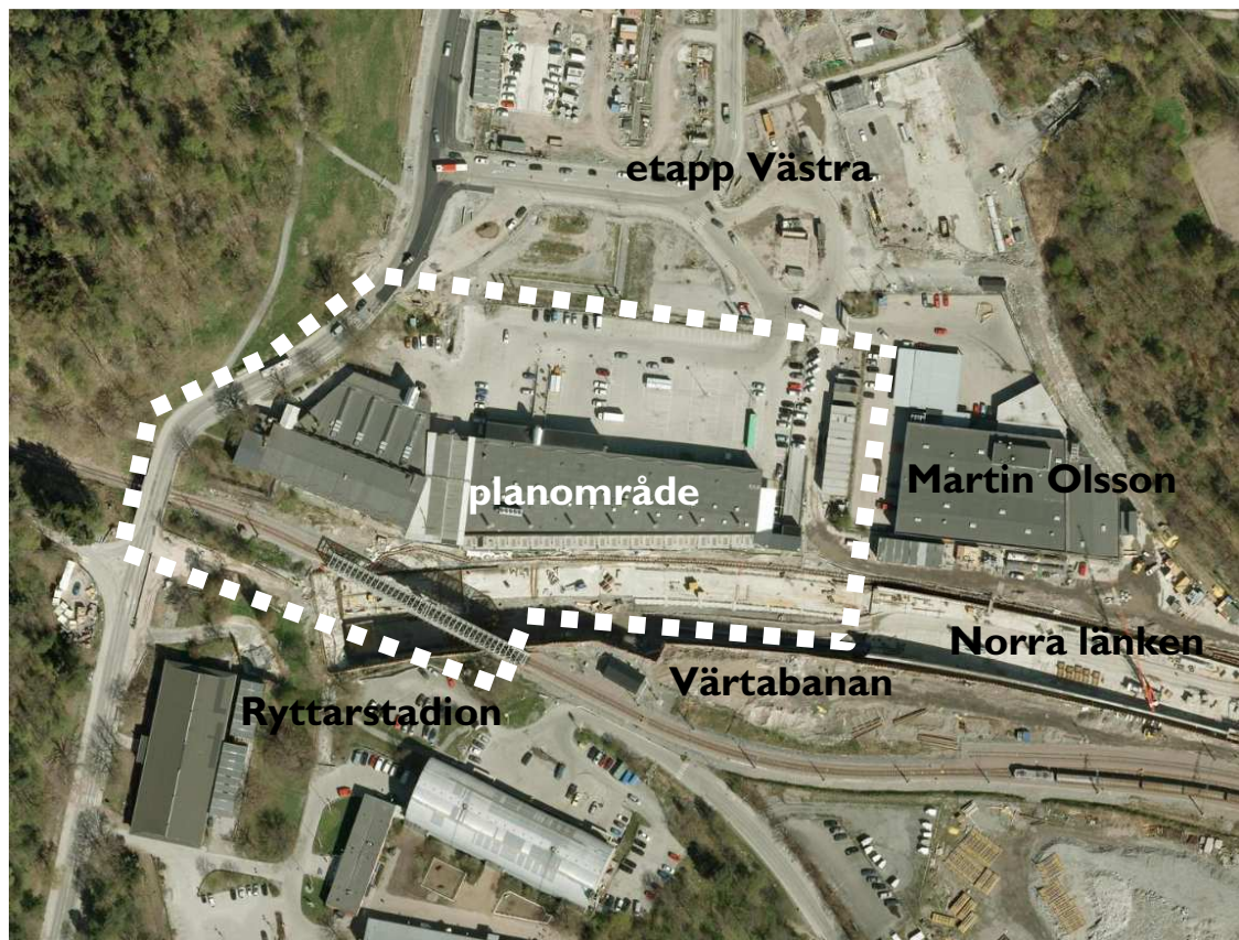
Ortofoto över planområdet (2010) under byggandet av Norra länken
