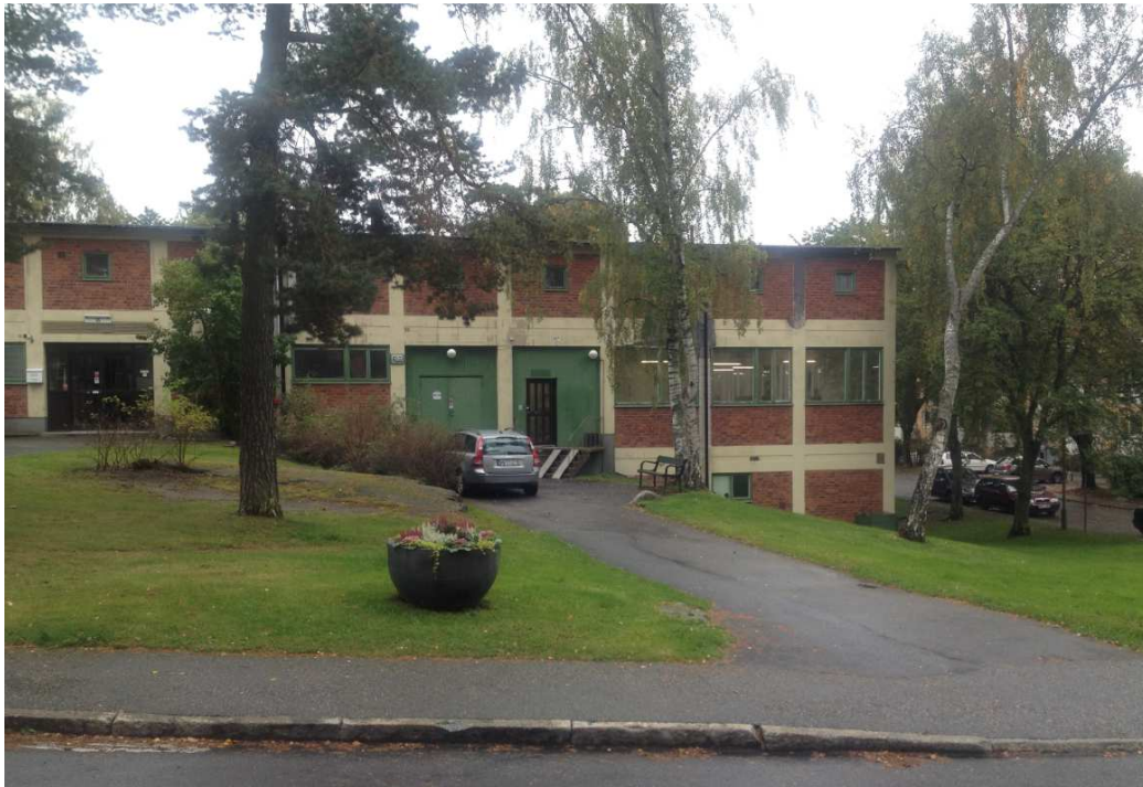
Panncentralen i Tallkrogen är ritad av arkitektkontoret Anker Gate Lindegren Arkitekter AB, ett under 40-50 talen inflytelserikt kontor inom Svensk arkitektur, som också ritade bostadshusen i området.
