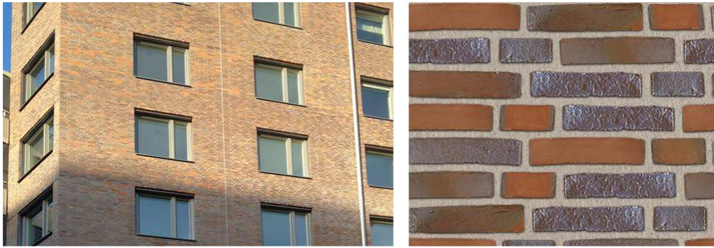
Fasadmaterial bostadshus: tegel i rödbrun kulör. Bild: Erséus
