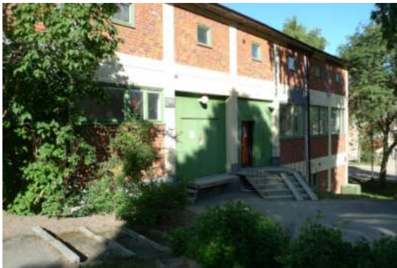
Värmecentralen i Tallkrogen uppfördes mellan 1949 – 1952. Bild från nordost 2013-07-09. Foto Hanna Gårdstedt SSM.
