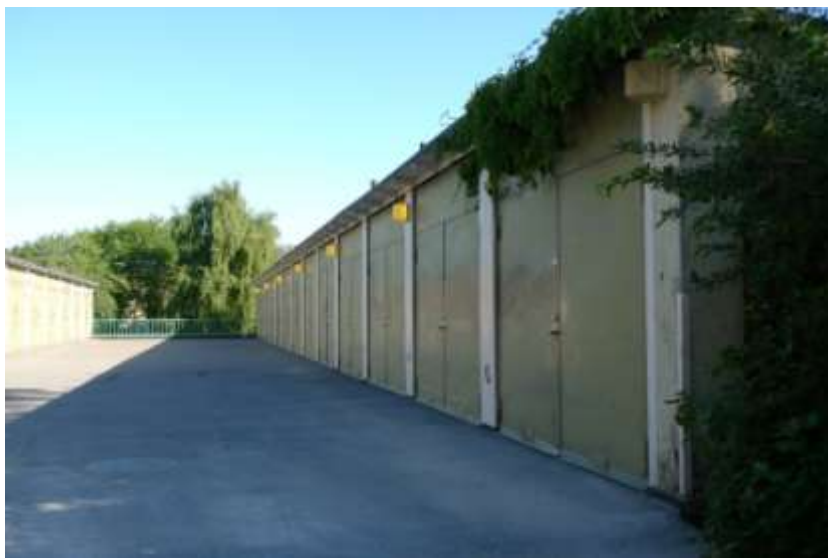
Ursprungliga garagelängor på taket från söder. Bild 2013-07-09 Hanna Gårdstedt SSM.
