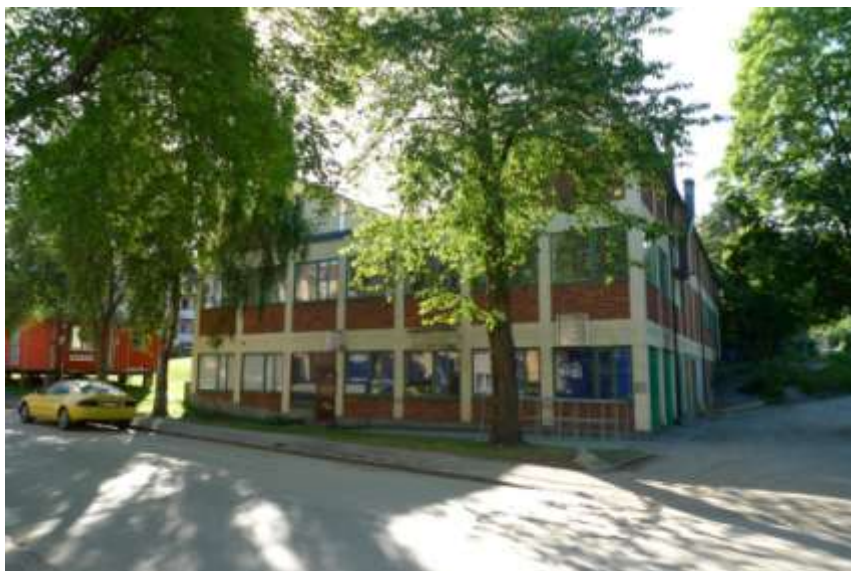
Värmecentralen från nordväst.
